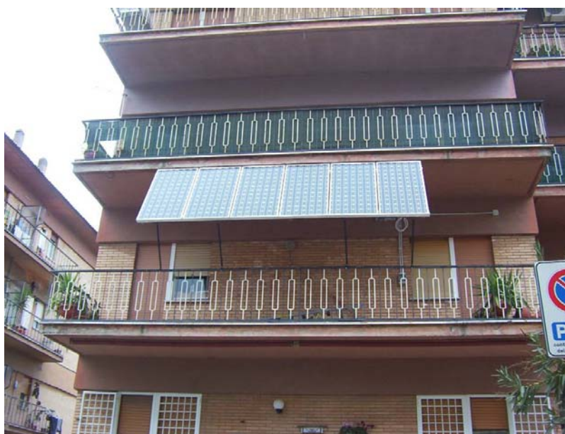
Figura 23 - Esempio di installazione non idonea alla classificazione dell'impianto fotovoltaico nella categoria "su edifici" – Motivazione: la lunghezza dell'impianto fotovoltaico supera il doppio della lunghezza delle aperture trasparenti sottese
